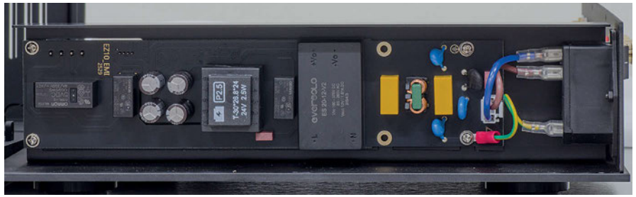
Figura 2. La struttura scatolata che scherma il contenuto costituito dal filtro di rete e due trasformatori per fornire tensione ai circuiti di servizio.
